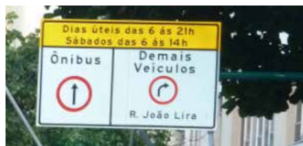
FIGURA 3.12 – SINALIZAÇÃO VERTICAL (PLACA) DE VIAS TRANSVERSAIS COM GIRO À DIREITA AO LONGO DO CORREDOR BRS
