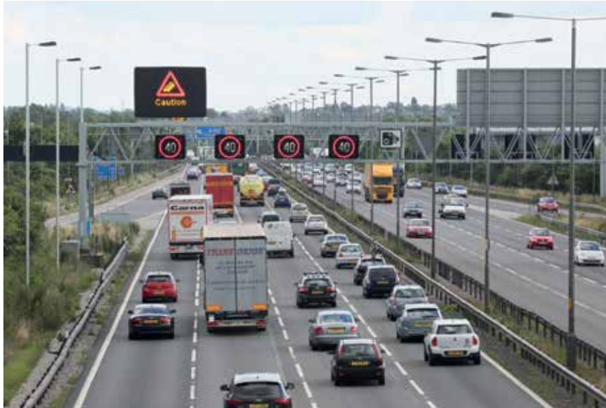
Figura 2 - Velocidade dinâmica em estradas inglesas [Highways England]
