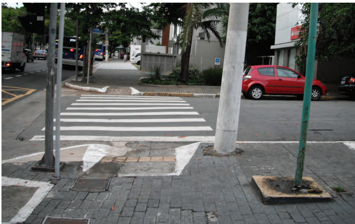
Figura 16: Acessibilidade na faixa de pedestre, Av. Sumaré
