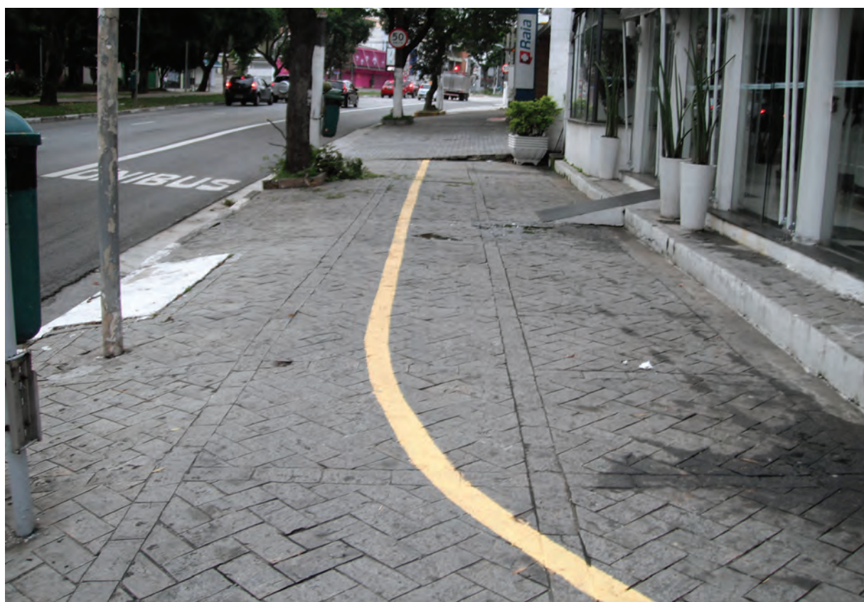
Figura 6: Qualidade da calçada, Av. Sumaré
